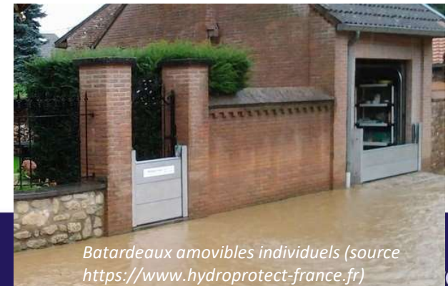
Barrières amovibles (source ESTHI) pour les longueurs importantes, un poteau intermédiaire doit être prévu.
