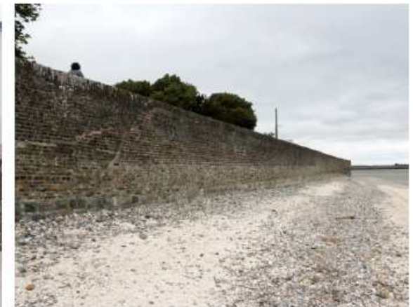
• Côté mer : mur briques toute hauteur
