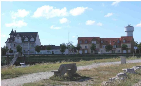
Constat similaire, ici sur la digue Mercier
