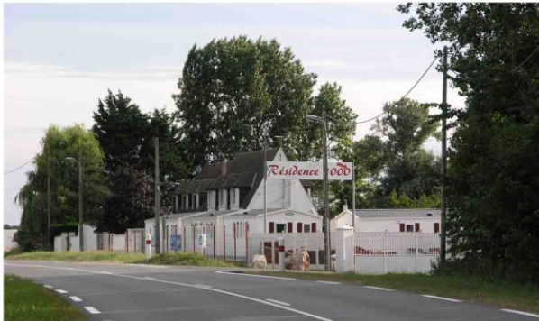
Impact visuel de cet ensemble isolé
