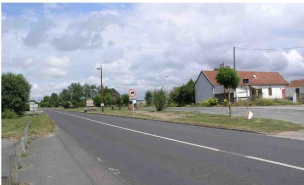
Lecture difficile de la structure urbaine, densité peu marquée, largeur de l'espace public. Surface en eau des carrières à l'arrière plan.
