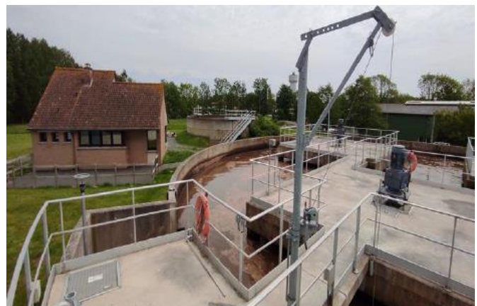
Photo de la station d'épuration
