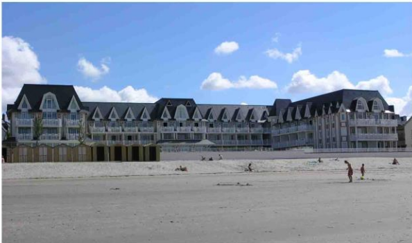
De grands ensembles pour l'hébergement touristique, ici une construction récente sur le front de mer
