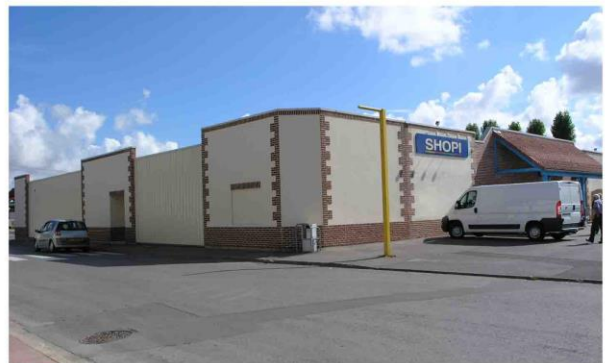
Recherche d'une meilleure intégration au tissu bâti environnant par l'usage partiel de la brique
