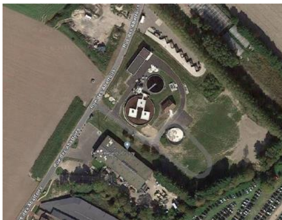
Photo aérienne de la station d'épuration
