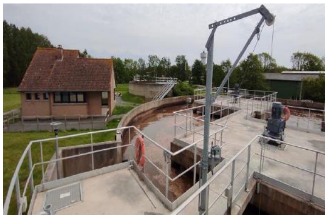
Photo de la station d'épuration
